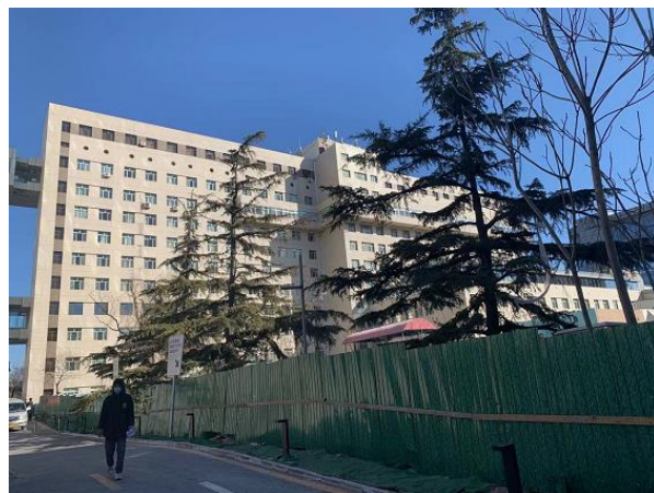
东侧老病房楼现状照片
